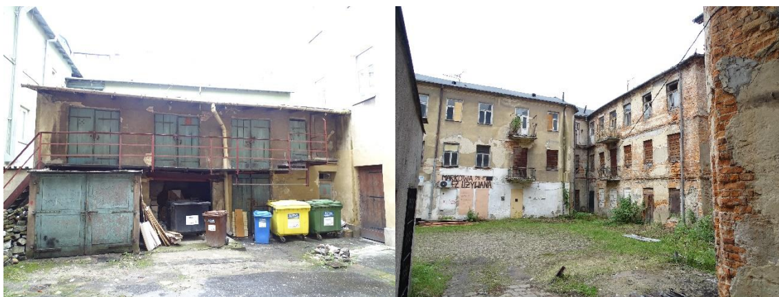
Zdjęcie 2.5 - przestrzenie półpubliczne (zdjęcia wykonano na zlecenie UM Lublin).
